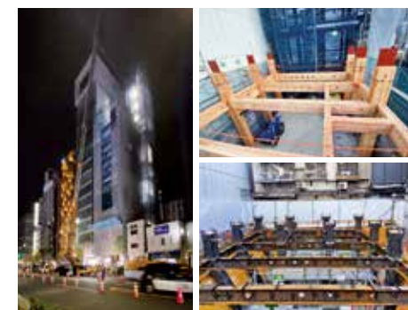
左/木造建て方施工状況 右上/9階木構造建て完了時 右下/地下0節鉄骨建て完了
