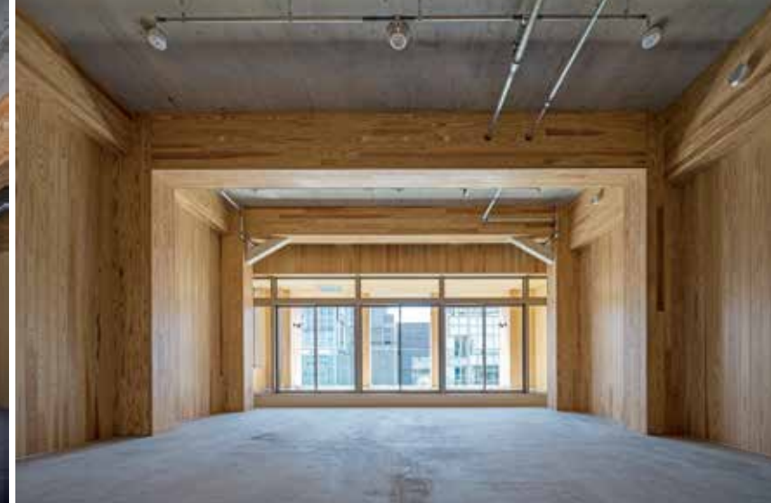
10階内観 木造ラーメンフレームの躯体を活かし、内装壁にも外装同様多摩産杉材を用いた
