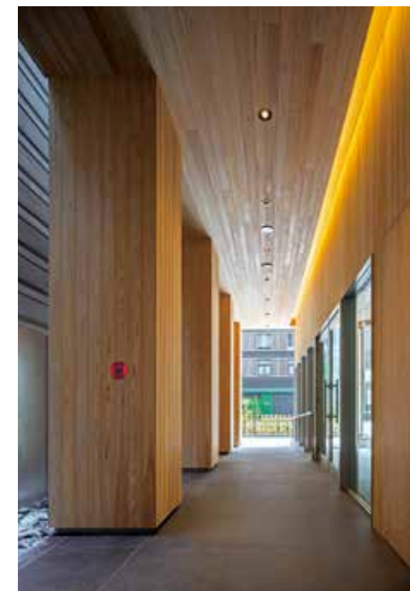
左/1階共用廊下 多摩産杉材により木質化された共用廊下は銀座の街路と連続する 右上/オフィスフロア 地区計画において建築可能な最高高さとするので、4.5mの階高を確保した 右下/地下1階 既存躯体を山留め壁として有効利用しながら、新築の構造体を斜めにセットアップしている
