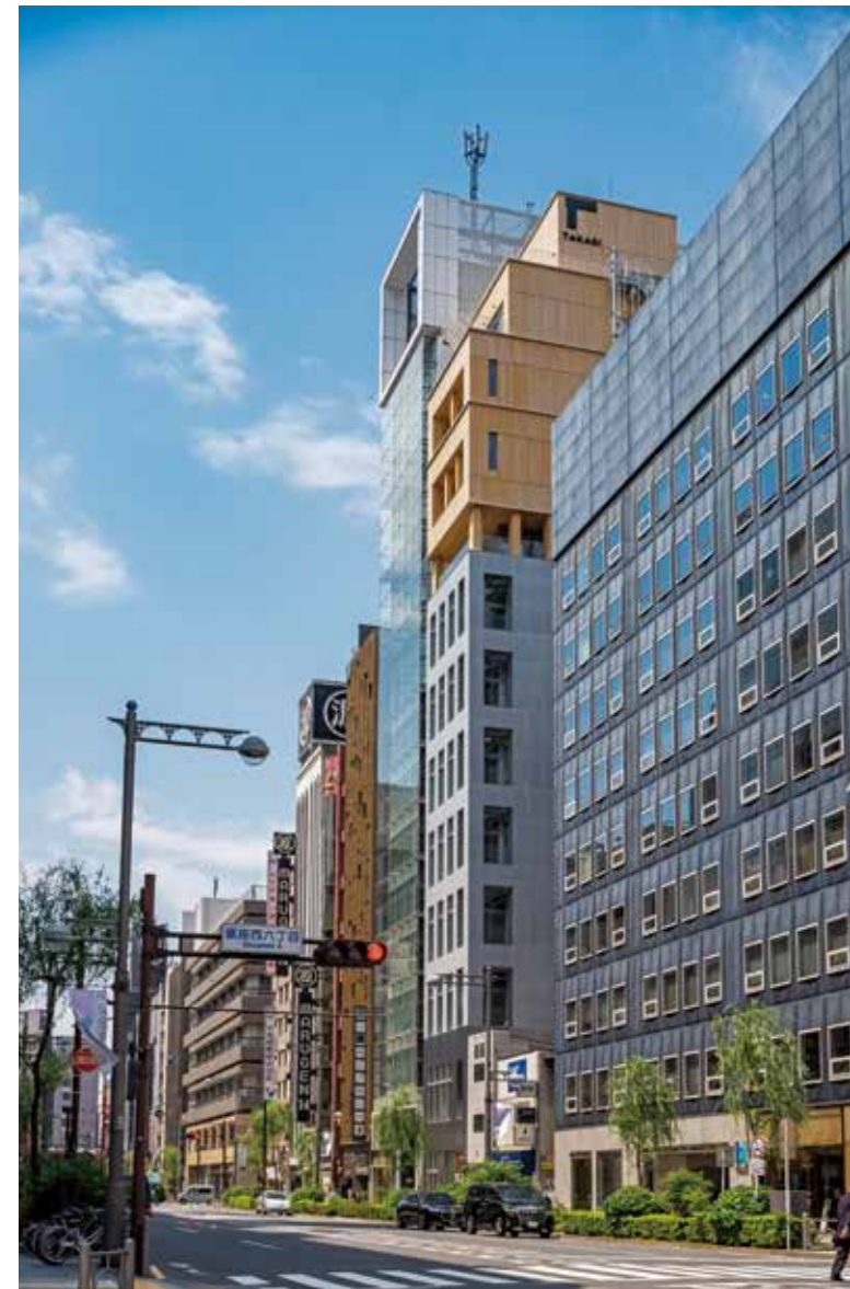
上／西銀座通り(外堀通り)から見る。1～8階が鉄骨造、9～12階が木造。高さ56mの複合商業ビル 左頁／1966年に建てられた「有賀写真館ビル」が老朽化により取り壊され、地上12階建てビルへと建替えられた
